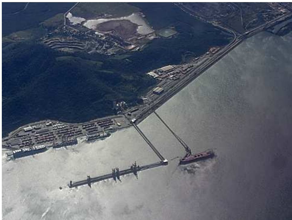
Figura: Vista parcial do Porto de Itaguaí.
