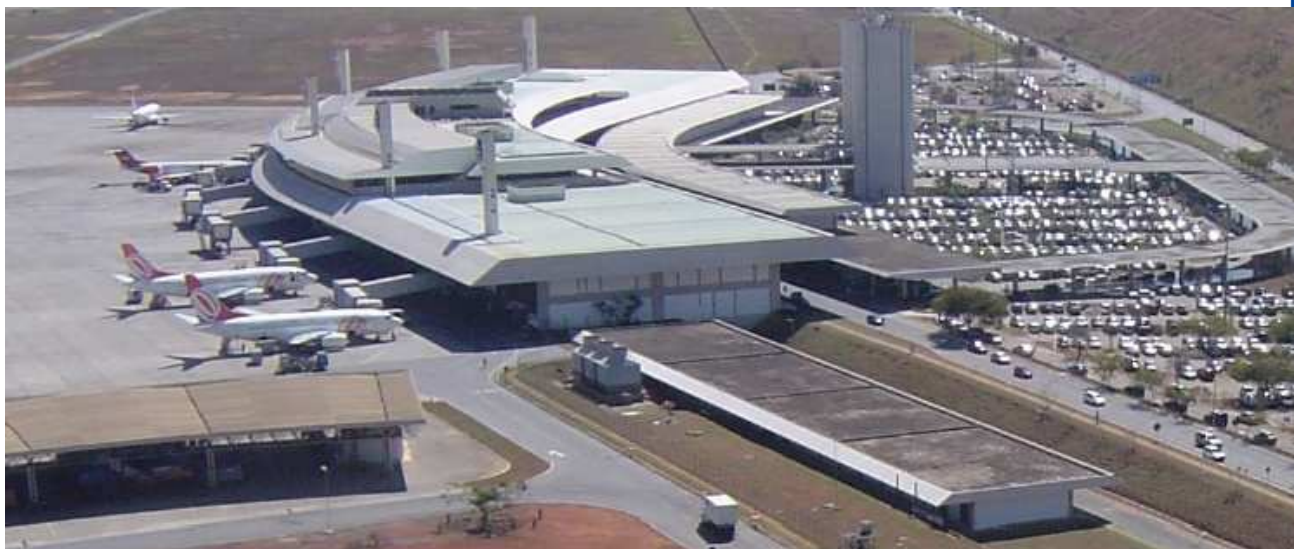
Figura: Vista parcial do Aeroporto Internacional Tancredo Neves
